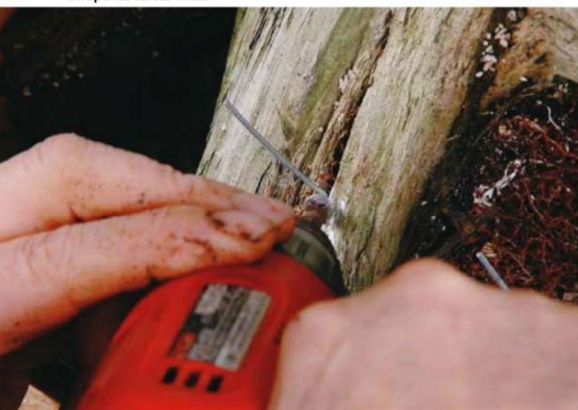
(24) En uno de los agujeros, vemos que la madera seca está agrietada, por eso colocamos un par de tornillos, para atarlo de manera más segura. Lo primero es la seguridad del trabajo.
